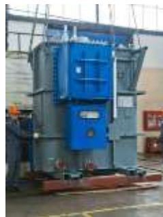
Такелаж трансформатора
