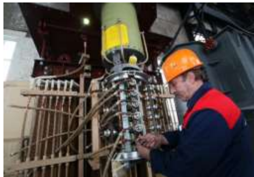
Установка переключающего устройства
